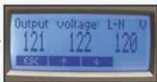
Mostrar tensión de salida del módulo individual
