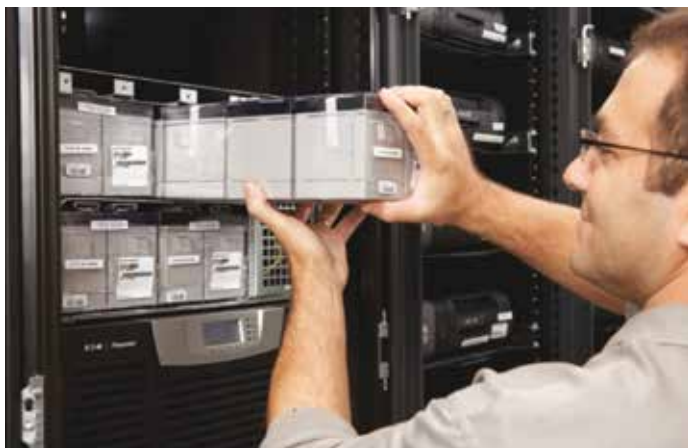
El personal de informática puede fácilmente reemplazar los módulos de batería.
